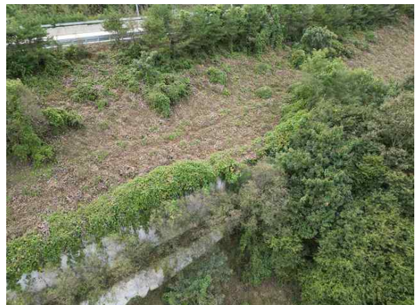
상부 성토부 전경
