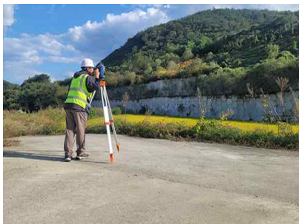
광파기를 이용한 측량 작업
